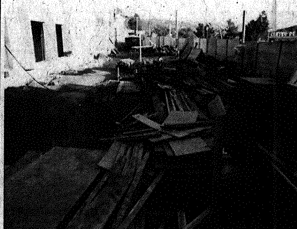
Fotografía N° 6: Diferentes materiales dispuestos sin orden en la zona trasera de la edificación.
